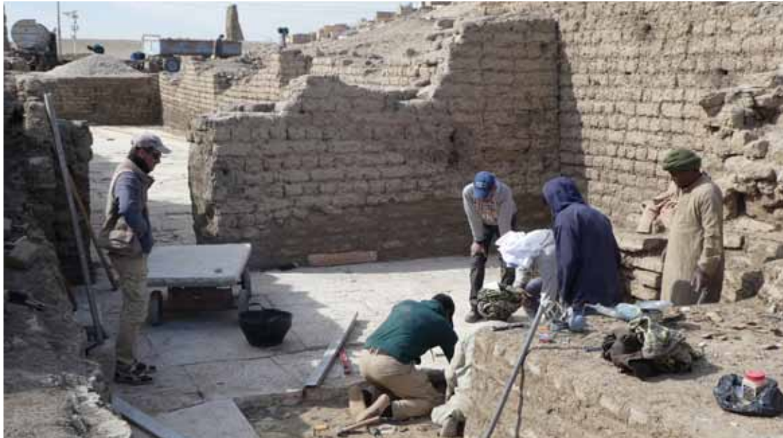
A.- Ramesseum. Secteur STF. Pose de dallage à l'entrée du vestibule conduisant aux ateliers, et percement d'une ouverture dans le mur en brique crue mis en place au cours de la Troisième Période Intermédiaire. [Cliché © Christian Leblanc].
