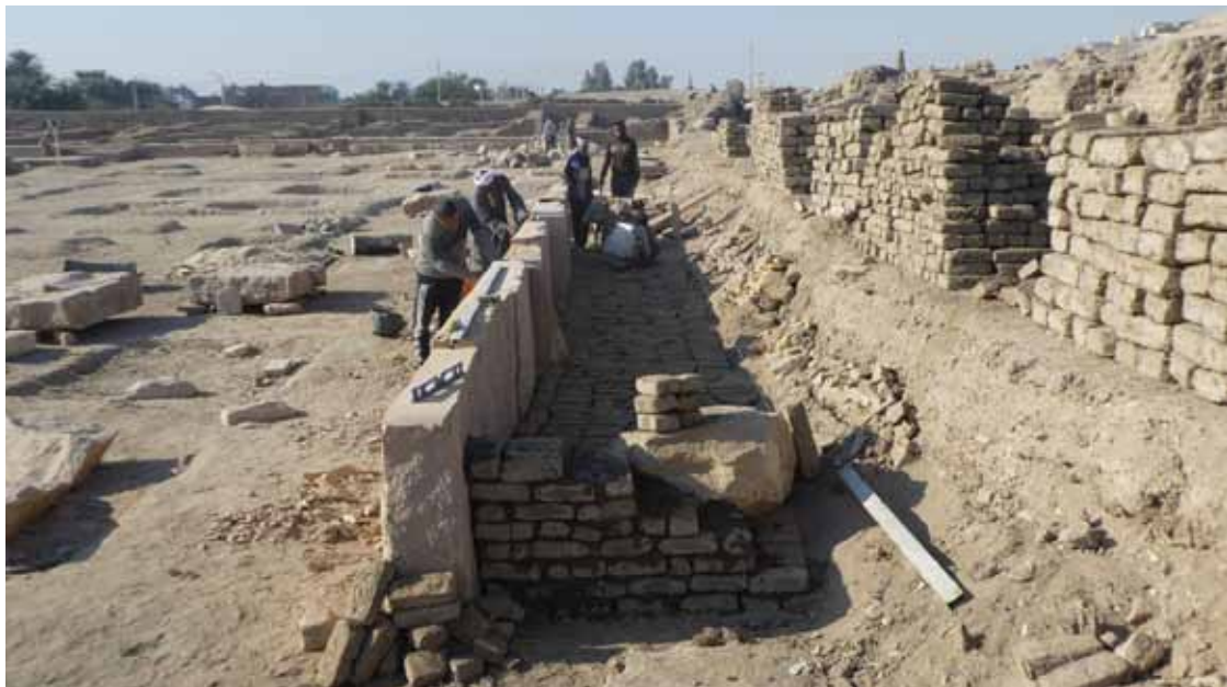
B.- Secteur ZST. Construction d'un contrefort en briques crues pour contrer la poussée des déblais de la terrasse (DBO) et maintenir le parement de pierre du mur ouest du temple. [Cliché © Christian Leblanc].
