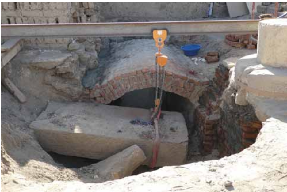
B.- Travaux de levage d'une dalle provenant du plafond de la salle à colonnes STI.TR (annexe du Trésor) et barrant la descenderie de la tombe de Sehetepibrê. [Cliché © Cliché Christian Leblanc].
