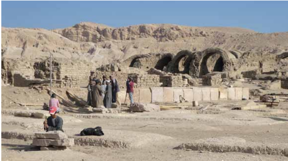
A.- Ramesseum. Secteur ZST. Mise en place de blocs en grès pour matérialiser le parement est du mur occidental du temple. [Cliché © Christian Leblanc].
