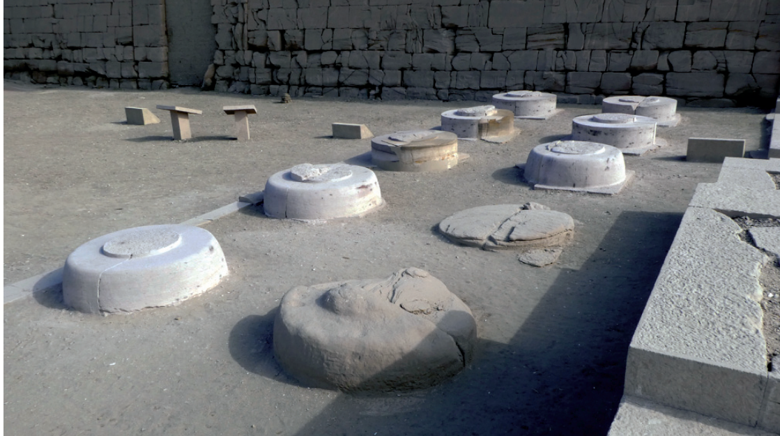
A.- Ramesseum. Première cour (PCR). Portique sud, en façade du palais royal. Restitution de huit bases de colonnes manquantes. [Cliché © Christian Leblanc].
