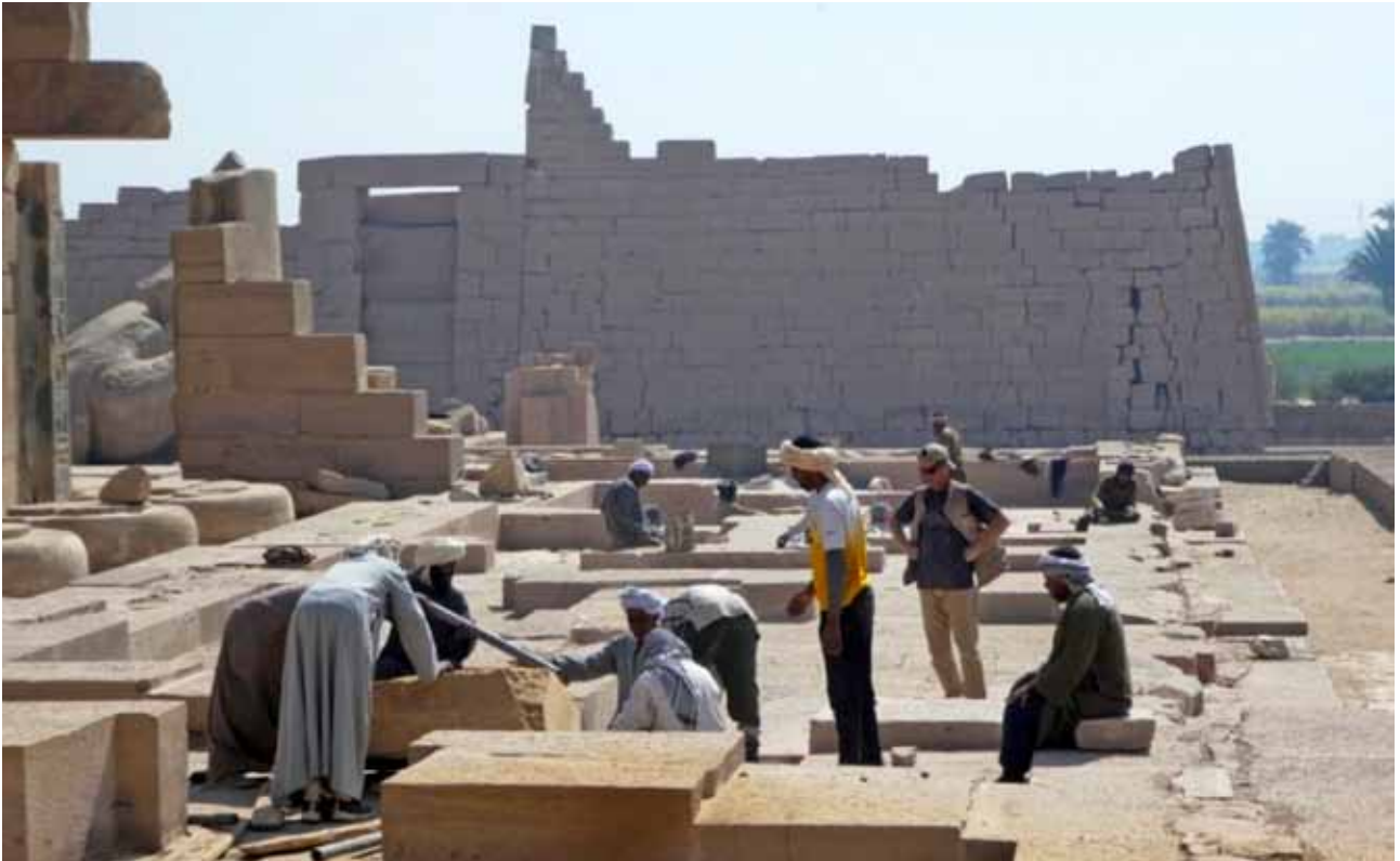
A.- Travaux de restauration des structures en pierre dans le secteur BCS (Bas-côté sud du temple). (Cliché Christian Leblanc).
