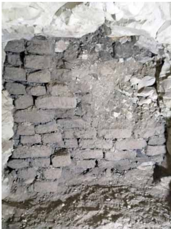
A.- Porte d'accès à la tombe STI-TR.To08 avec blocage en brique de terre crue encore en place. (Cliché Sameh Mohamed Zaki).
