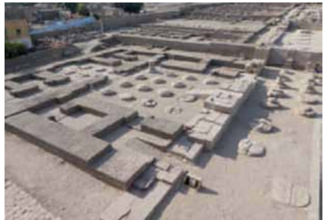
8 . Le palais royal après la restauration de ses structures. [© Cliché Christian Leblanc].
