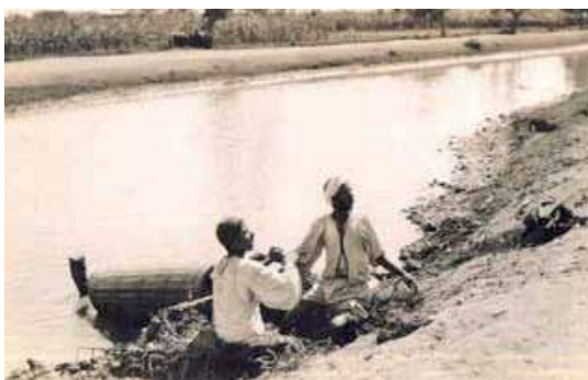
La vis d'Archimède. الطنبور (المضخة) المستخدم في رفع المياه.
